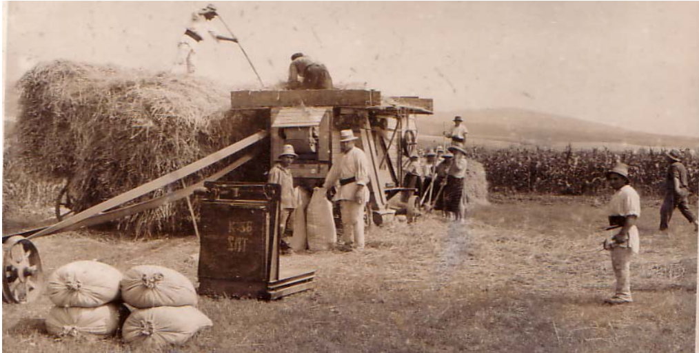
Fig. 3.26. Treieratul cerealelor păioase cu batoza acționată de locomobilă (sau tractor).
